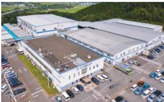
第2工場 ●兵庫県朝来市和田山町筒江 165-3
